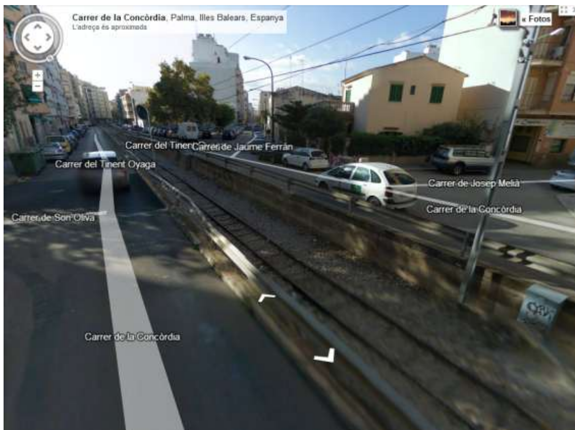
Fig. 21 – Trinxera del tren de Sóller que caldria superar amb un pas a nivell o amb rampes adaptades al pas dels cicles i de persones amb mobilitat reduïda.
