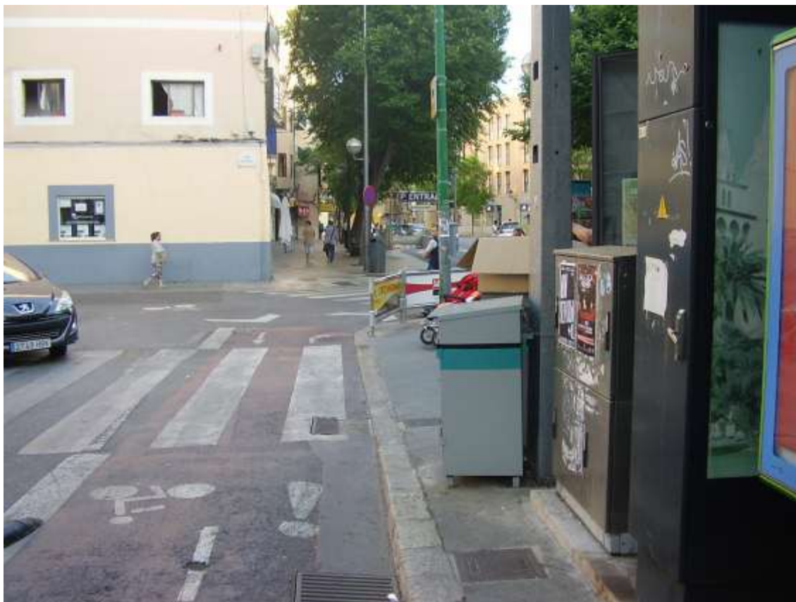
Fig. 20 – Encreuament a la Porta de Sant Antoni entre un carril bici i un pas de vianants, on aquests no poden veure l'amenaça d'un possible ciclista infractor circulant a gran velocitat.
